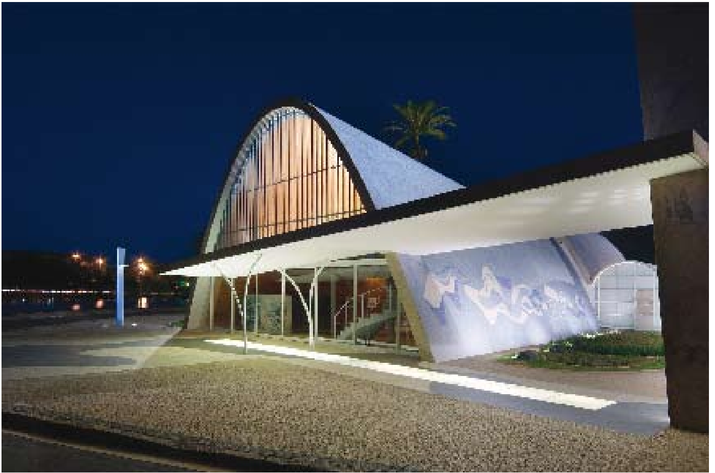
Na foto acima, iluminação da marquise e do brise enfatiza a transparência do projeto. Ao lado, cortes esquemáticos da iluminação do fosso (acima) e do brise (abaixo)
