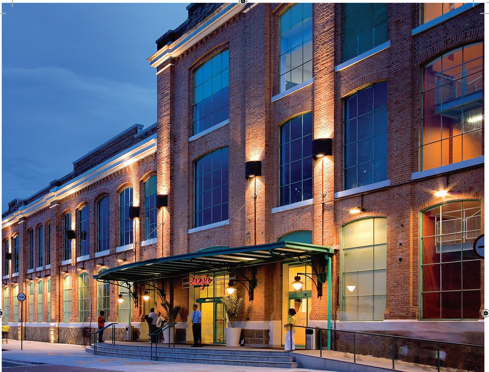
A iluminação das fachadas do Bangu Shopping, na zona oeste do Rio, foi feita com lâmpadas de vapor metálico de cerâmica de duplo contato
